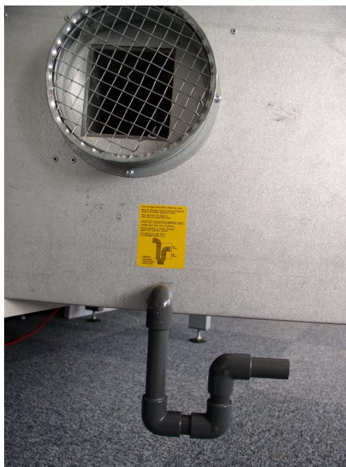
Figur 3: Etablering af vandlås (DUKA leverance)
